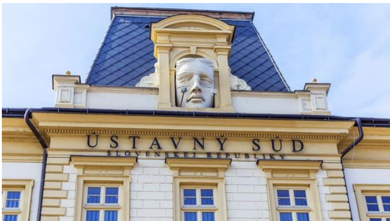
Obr. č. 25: Ústavný súd SR, Košice, osadená socha Justície v nadstavbe vstupného rizalitu
