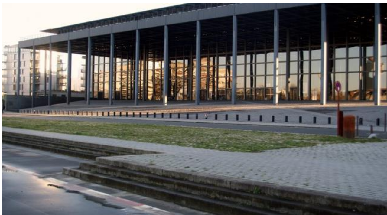
Obr. č. 26: Súd v Nantes, realizácia 1993-2000 (Jean Nouvel)
